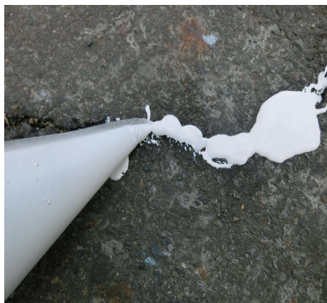
② ひび割れ部に流し込む
